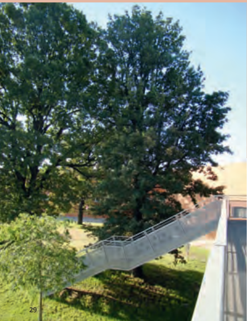
29. Vista di dettaglio della uscita di sicurezza del "giardino delle querce."
